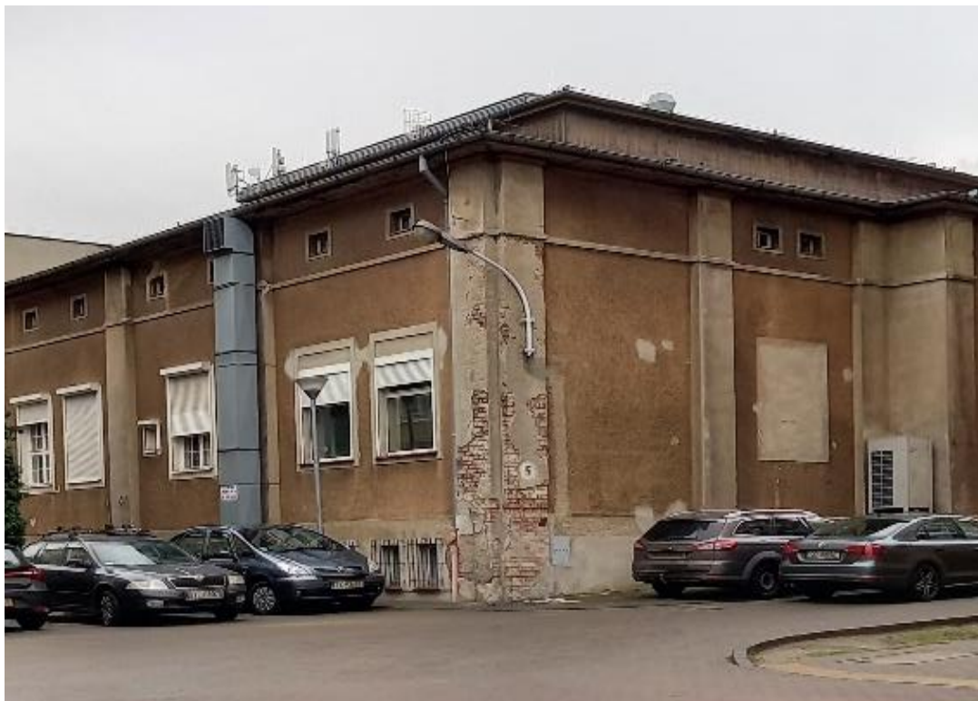
Zdjęcie nr 3 – Budynek 5A przeznaczony do rozbiórki.
