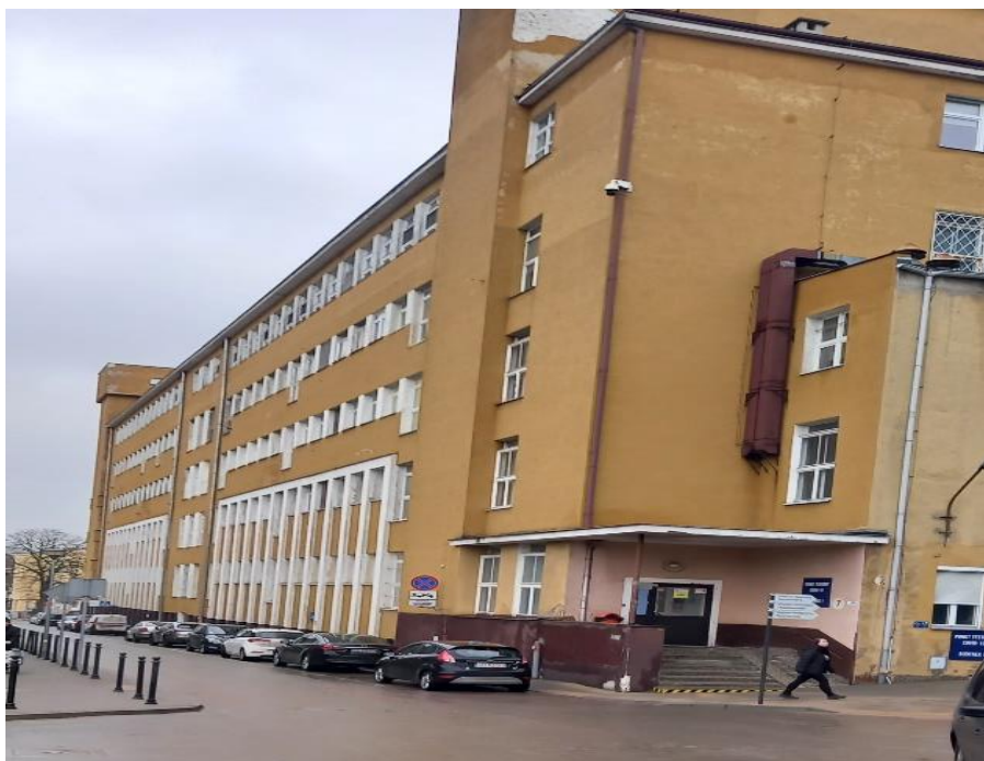
Zdjęcie nr 2 – Budynek nr 8 przeznaczony do rozbiórki.
