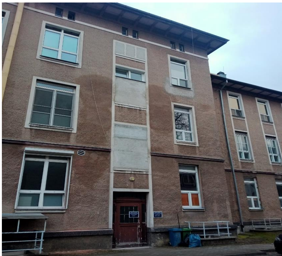
Zdjęcie nr 5 - Budynek nr 4 elewacja zachodnia.
