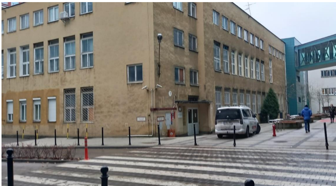
Zdjęcie nr 1 – Budynek nr 7 przeznaczony do rozbiórki.
