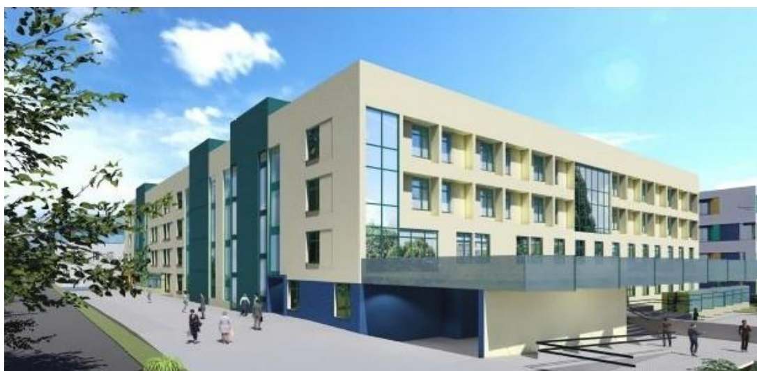
Widok – narożnik północno-zachodni
