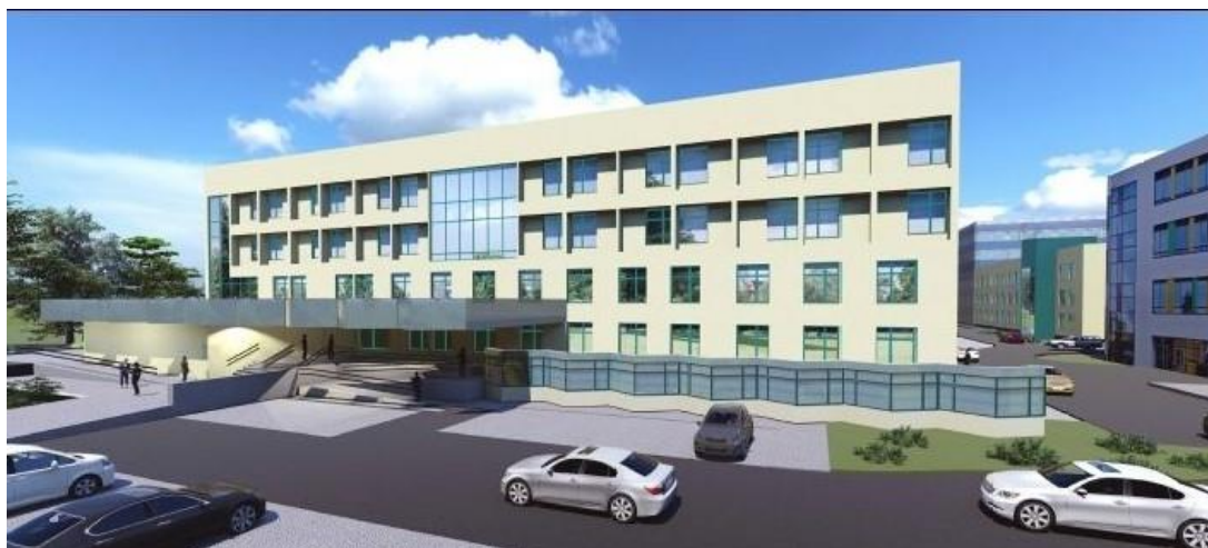
Widok od Parku Skowroniego – wejście główne
